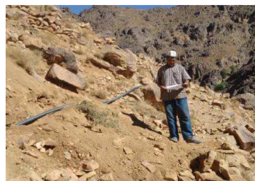
Vérification du tracé
