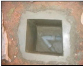
Intérieur d'un regard avant enlèvement de la partie supérieure du raccord
