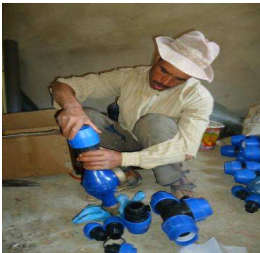
Formation à la pose d'un compteur
