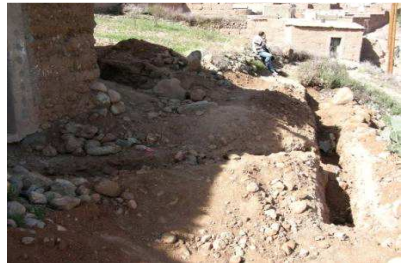
Tranchée et emplacement d'un raccordement de particulier
