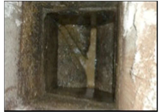
Intérieur du regard terminé
