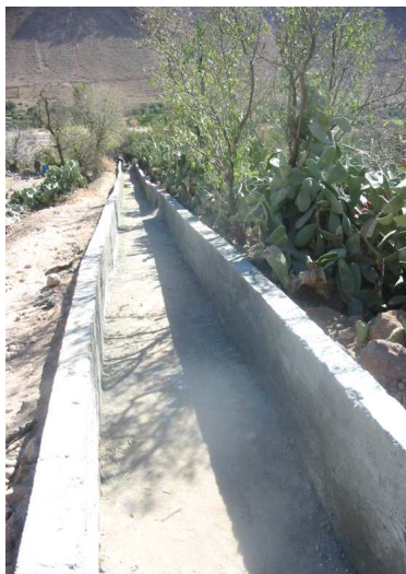
Canal d'évacuation des eaux pluviales du douar de Tagmoute.
