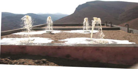
Un filtre en cours d'alimentation à Tagmoute
