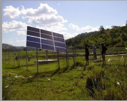
Pompage solaire au Timor Oriental Photo copyright Triangle GH
