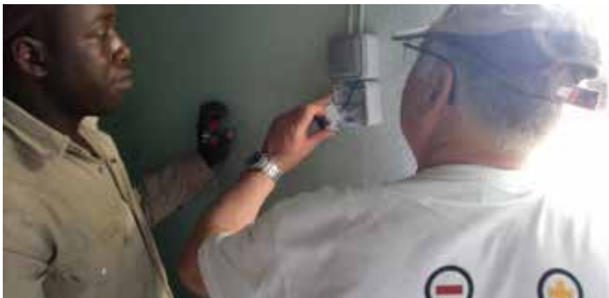
Vérification des installations, Gomponsom, Mali.
