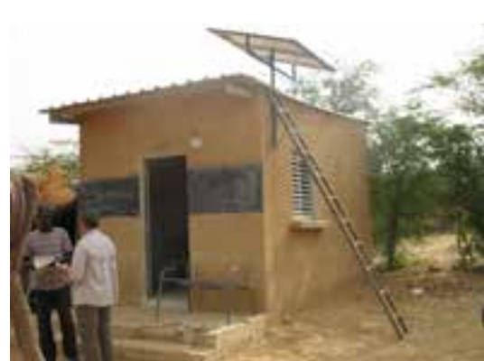
Évaluation des installations, Mboyo, Sénégal.
