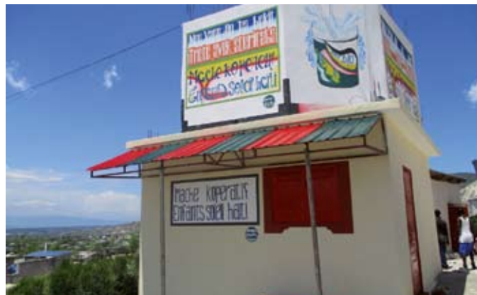
Fin des travaux de l'épicerie. © Fédération Enfants Soleil
