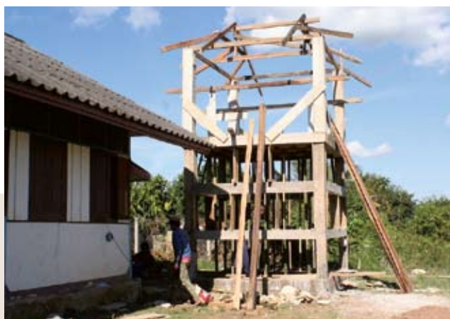
Construction du réservoir. © PEMM
