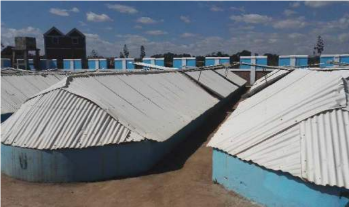
Figure 24 : Photo des toits actuels
